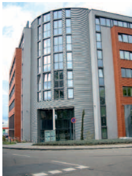
AUSSENANSICHT: Das Heidelberger Kanzlei-gebäude von Koch & Müller.
